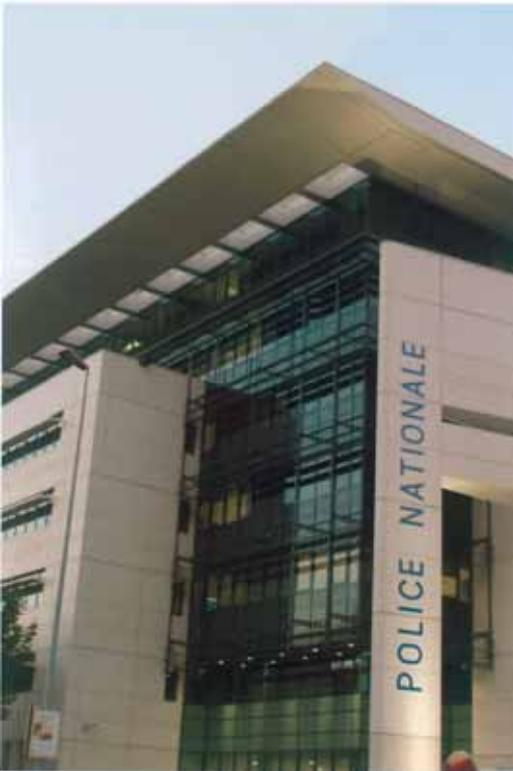
Los paneles de revestimiento fabricados en hormigón prefabricado bicapa y que contienen como árido mármol blanco de los Pirineos, se han pulido con un acabado brillante que aumenta la luminosidad ya típica de los productos TX. En total, 750 paneles (700 de ellos blancos) cubren una superficie de hormigón prefabricado arquitectónico de 5.400m<sup>2</sup>.
