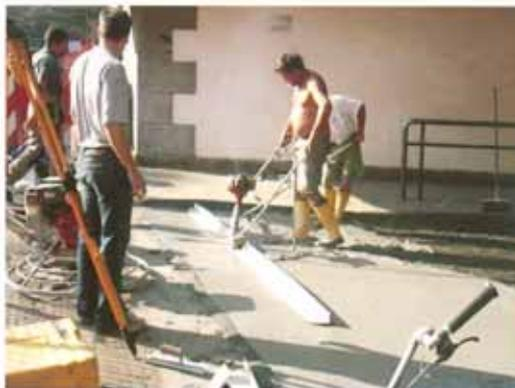
Distintas fases de la colocación del pavimento fotocatalítico: escurificación del asfalto existente, colocación, curado.
